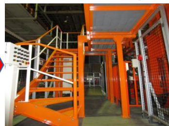
設備点検用ステージ 施工後
