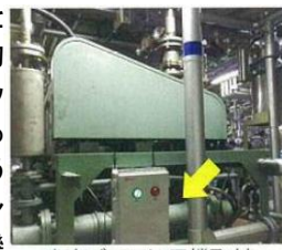
真空プロアに子機取付
