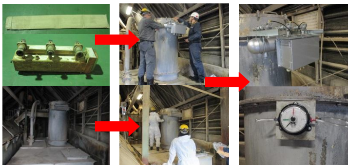
↓ 施工前 ↓ 施工中 ↓ 施工後
